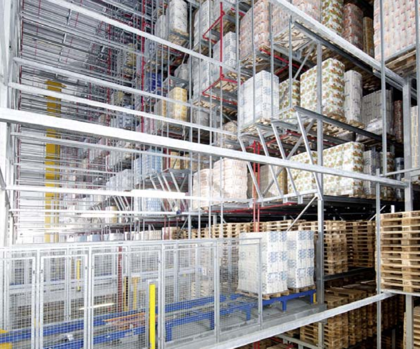
Im 36 m hohen, 9-gässigen Hochregallager stehen rund 60.000 Palettenstellplätze zur Verfügung.
