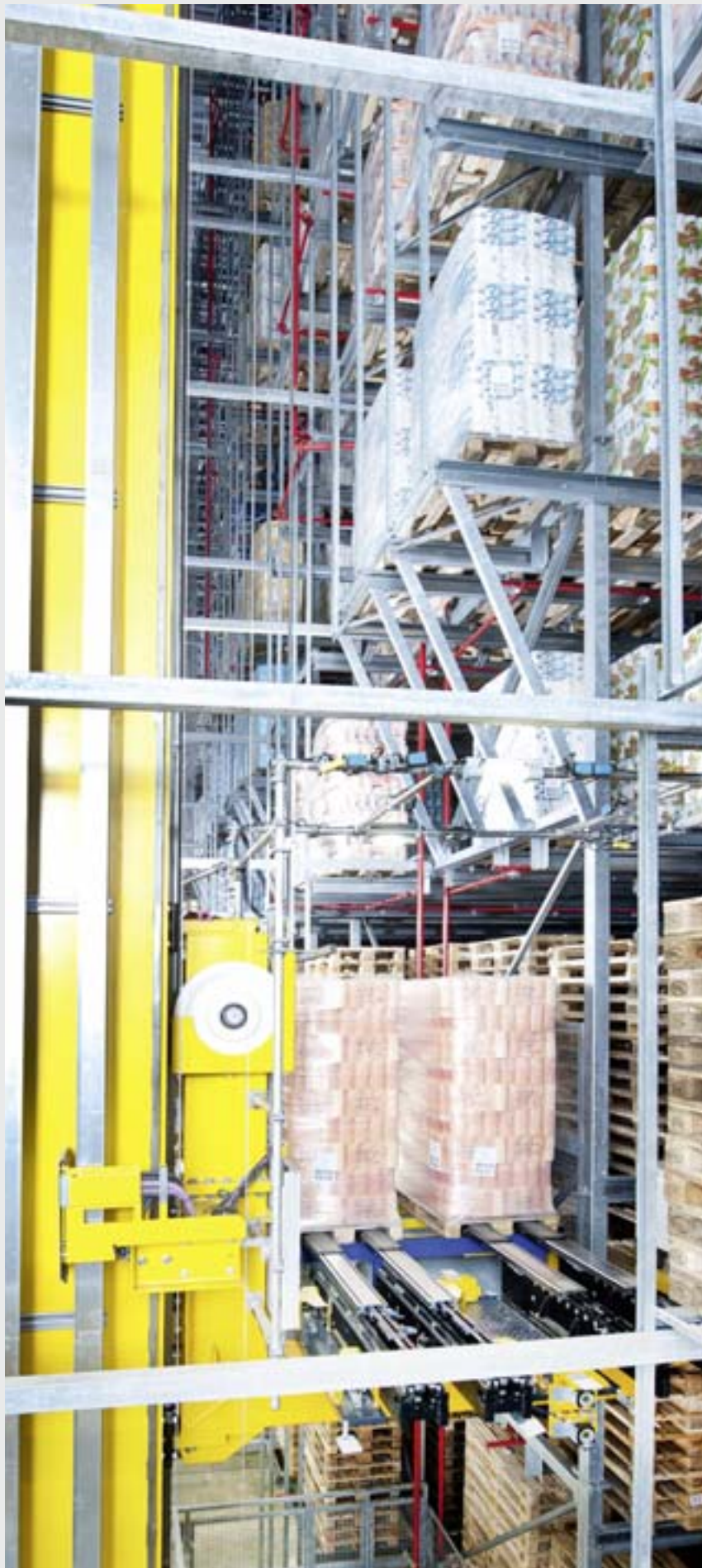
9 Regalbediengeräte mit je 2 Teleskopgabeln fahren in einer Geschwindigkeit von bis zu 230 m/min und einer Hubgeschwindigkeit von 70 m/min durch die Gassen.
