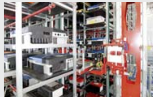
Im AKL sorgen fünf RBG für effiziente Ein- und Auslagerungen.
