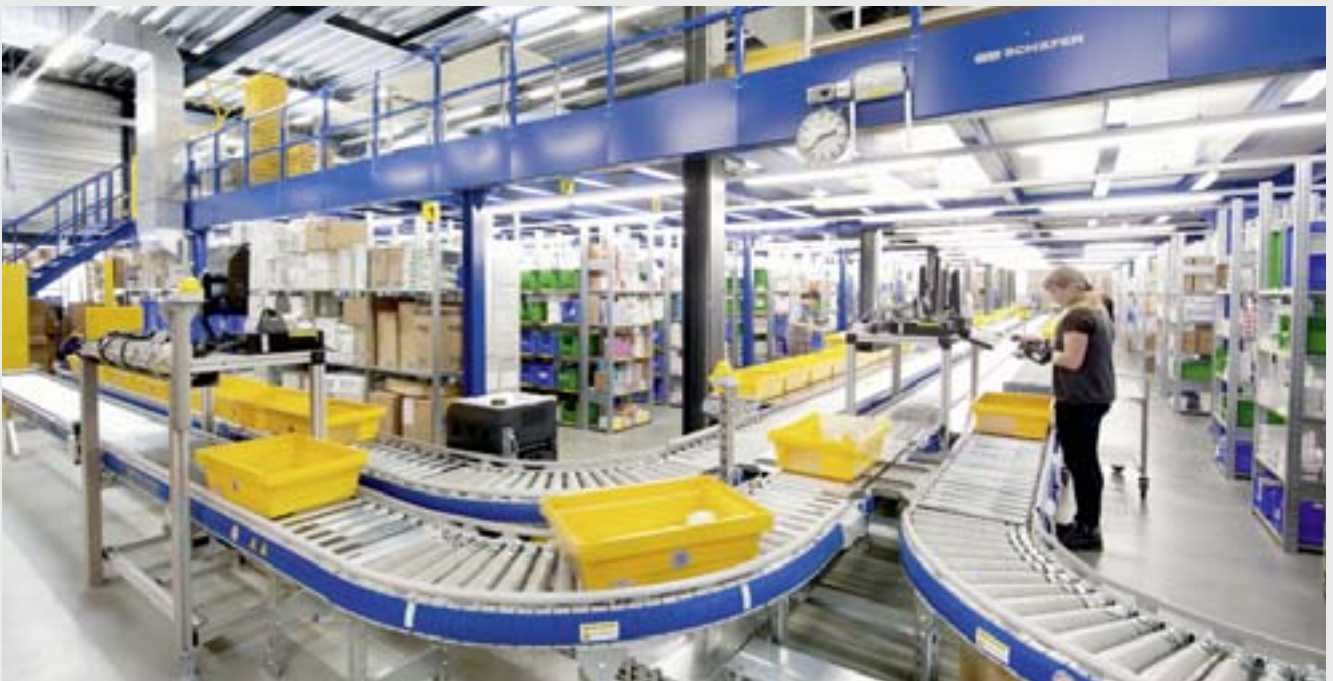
An die 80 m lange Förderstrecke sind 8 Kommissionierzonen angebunden.
