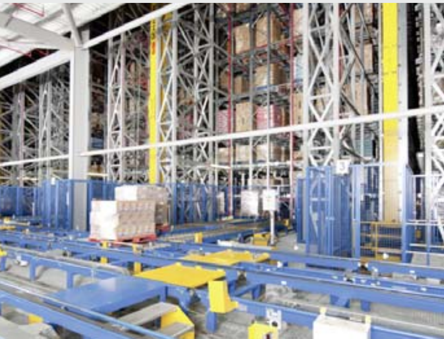
Hochregallager mit 11 Regalbediengeräten und 46.000 Stellplätzen.
