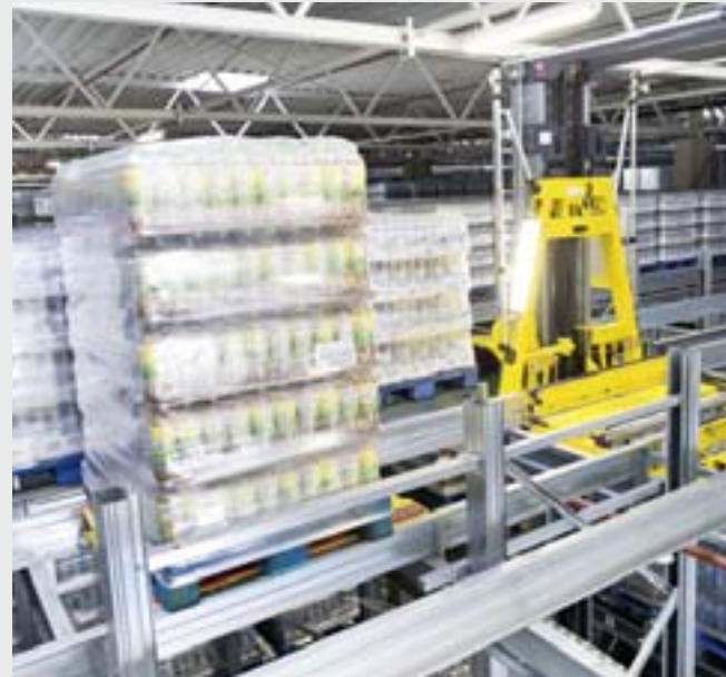
Gesteuert von der digitalen Wegmessung und Lichtsensoren setzen die Orbiter die Paletten durch leichtes Absenken punktgenau am vorgegebenen Stellplatz im Kanal ab.
