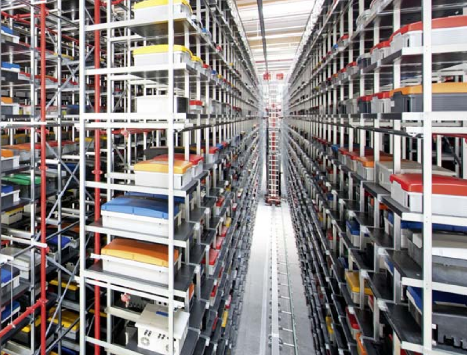
Automatisches Kleinteilelager mit integriertem Notfallkonzept, das eine variable Aufteilung der Gassen zulässt.
