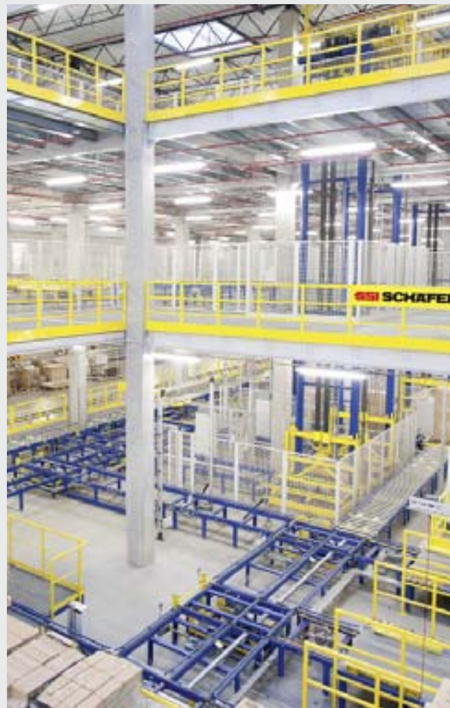
Vertikalförderer transportieren die Paletten auf die oberen Geschossebenen zur Übergabe an die Elektropalettenbahn.
