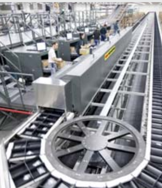
Pick-to-Bucket-System: Jedem Kommissionierplatz ist ein Sammelsystem mit 16 Trichtern zugeordnet.
