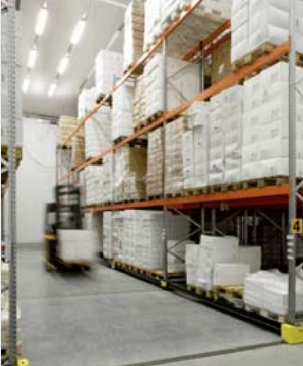
Die automatische Beleuchtungssteuerung sorgt dafür, dass die Deckenbeleuchtung nur in den aktiven Gängen eingeschaltet wird.
