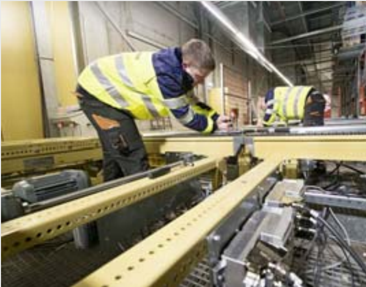
Modernisierung der Förderstrecke entlang der 9 Gassen des vorhandenen Hochregallagers, der Ein- und Auslagerstiche zu den Regalbediengeräten inklusive der erforderlichen Steuerungsmodernisierung und Anpassung der SPS-Programme.
