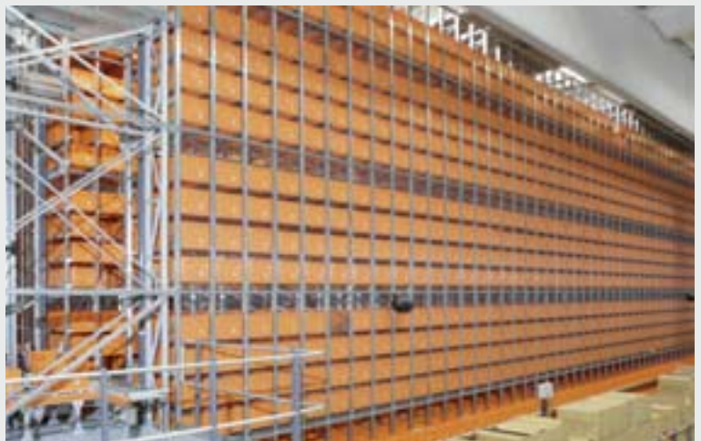
Nahezu 42.000 Behälterstellplätze stehen im AKL zur Verfügung.
