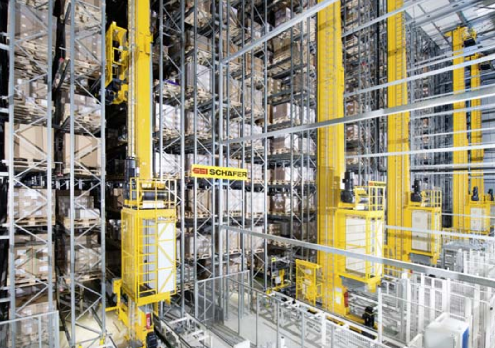
Das 8-gassige Hochregallager mit unterschiedlichen Temperaturzonen bevorratet rund 36.000 Palettenstellplätze für eine doppelte Lagerung.
